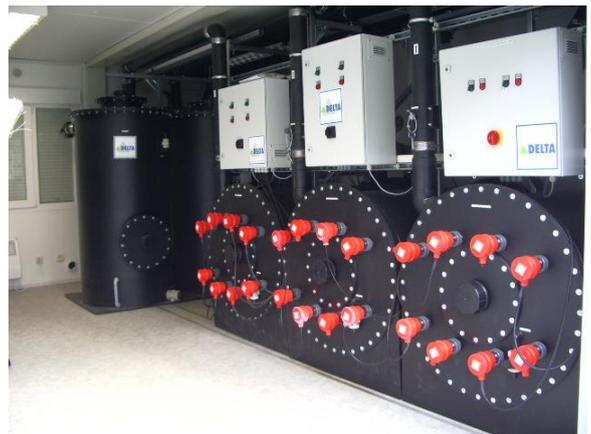
**Photolysereaktor zur Grundwasserbehandlung**
